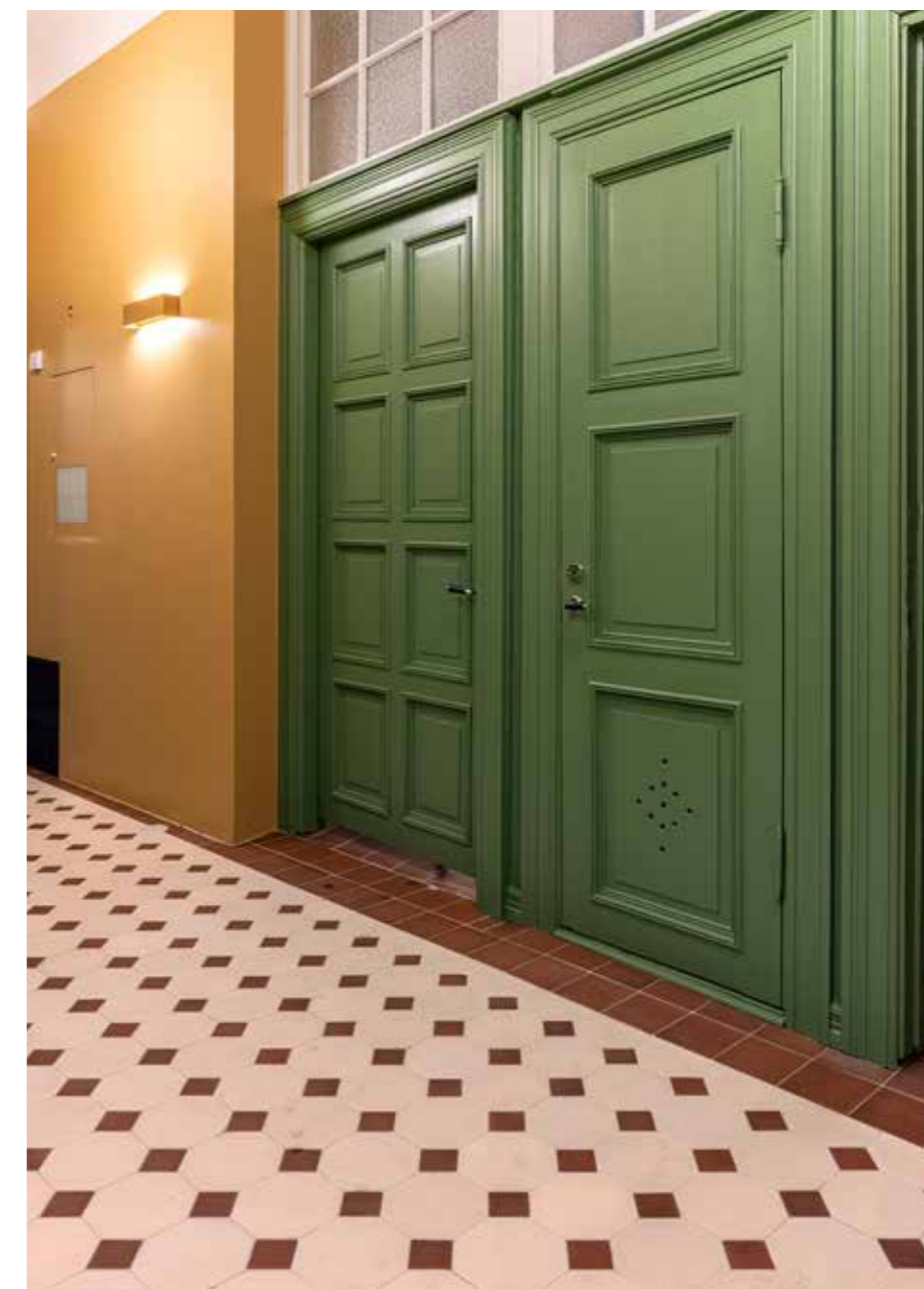
PÅ BILDET SEES originalflisen fra 1900. Kopi av originalflis fra 1900-tallet er benyttet i store deler av 1 etasje. Skapveggen vender inn mot behandlingsrom og tidligere damegarderober.
