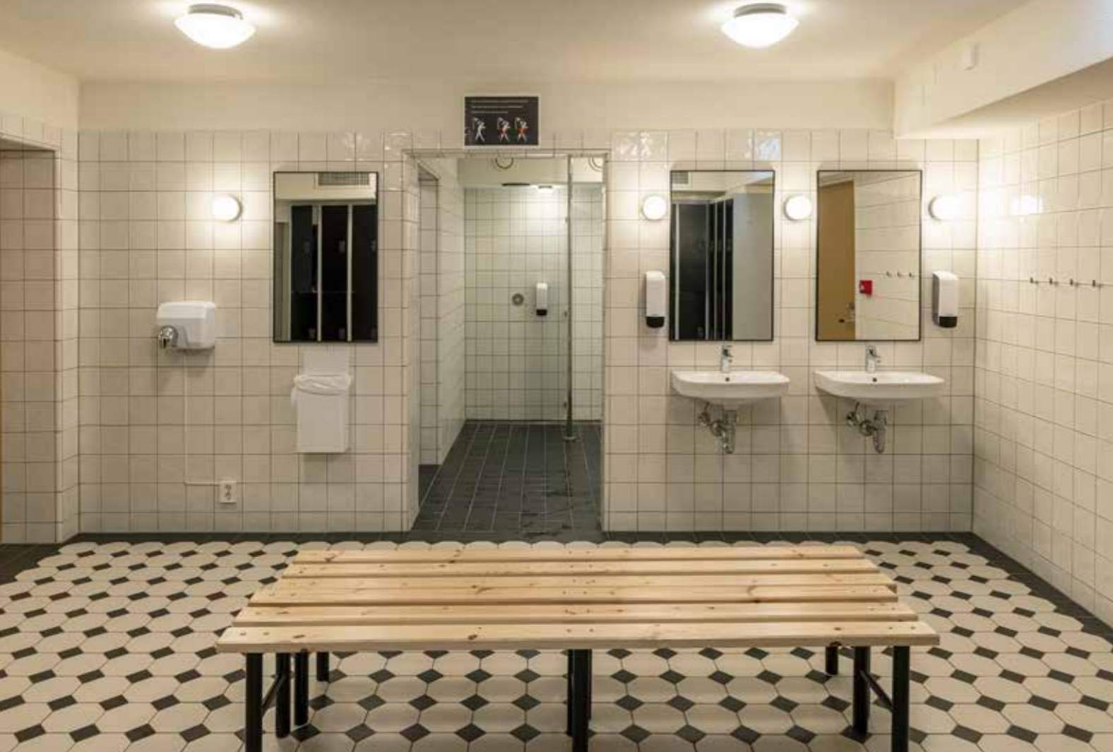
DENNE TYPE GULVFLIS ble funnet under flere lag. Kopi er lagt der den ble funnet. Rommet var Rullerom i bygget på 1900-tallet, og er nå ny skolegarderobe. Originalgarderobene i halve badet er restaurert og tilbakeført.
